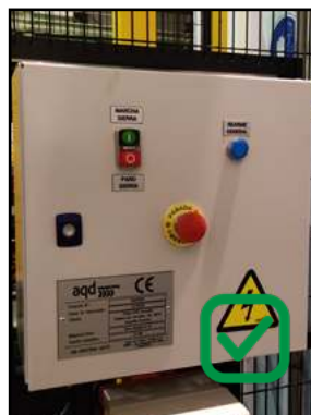
Ejemplos de armarios, botoneras y cableado en buen estado.
