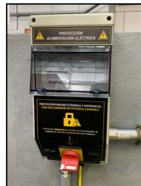
Ejemplos de dispositivos de desconexión de potencia con protección magnetotérmica y diferencial, y neumática (cuando proceda). Enlace web a la protección de alimentación eléctrica
